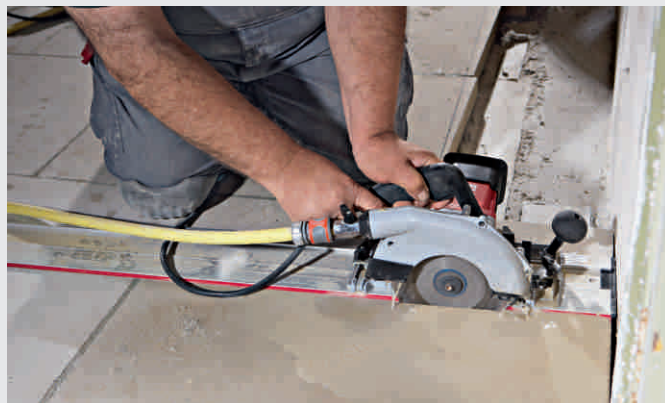
Бесступенчатое установление глубины резания 0-60 мм (с направляющей шиной 0-54 мм) в особенности подходит для изготовления деформационных швов и чистовой отделки ребер при изготовлении полов.
