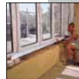
Тип AL 1L: установка подоконников.
