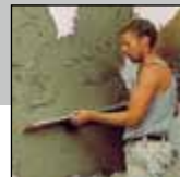
Тип TRK: затирка нижних слоев штукатурки.
