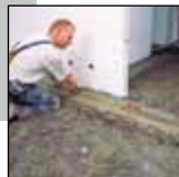
Тип AL 2L-2G: выравнивание материала бесшовного покрытия.
