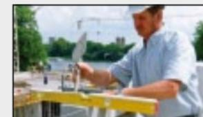
**Тип 96-2 K:** запатентованная антивибрационная система. Коррекция отклонений выполняется непосредственно путем легких ударов кельмой.
