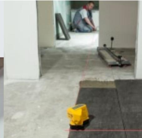
С помощью напольного лазерного прибора FLS 90 можно работать непосредственно на лазерных линиях – это экономит время и гарантирует высокую точность выполняемой работы.
