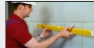
На корпусе приводятся все общепринятые единицы измерения для монтажа: произвести выравнивание, маркировку, сверление.
