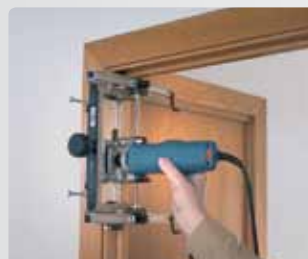
Фрезерование посадочного места верхней петли в дверной коробке.
