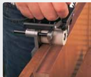
Облицовка верхней поверхности на двери с притвором.
