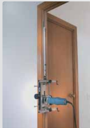
Фрезерование посадочного места верхней петли в дверной коробке.
