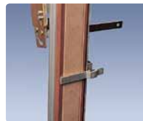
Закрепление дверной коробки в шаблоне
