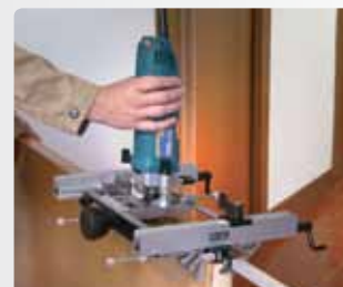
Фрезерование посадочного места верхней петли в полотне двери.
