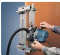
Выполнение пазов для установки кнопок, запорного цилиндра и других механизмов.
