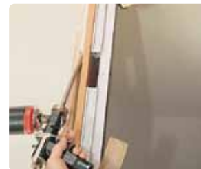
Заполнение полиуретановой пеной.
