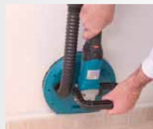
Обработка зон стыков при демонтаже сегмента защитного коврика.
