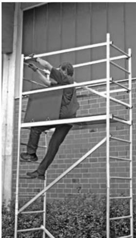
Базовая конструкция с первой надстройкой
