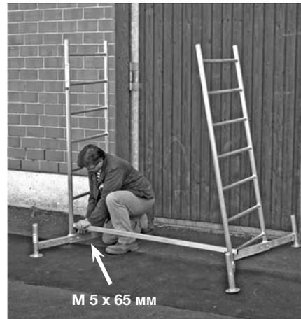
Базовая конструкция с первой надстройкой
