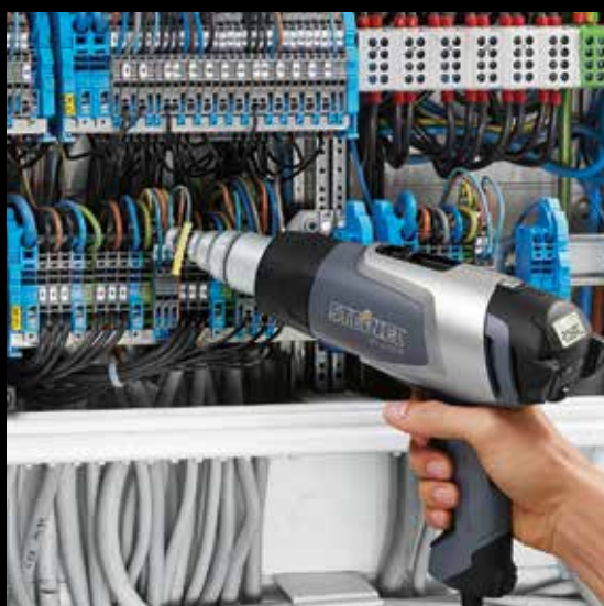
Обжим кабельных муфт в распределительном шкафу
