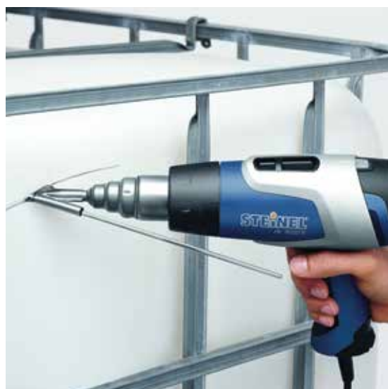
Ремонт. Заваривание ПВХ-бака для воды
