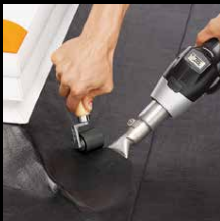
Сварка внахлест HG 2620 E
