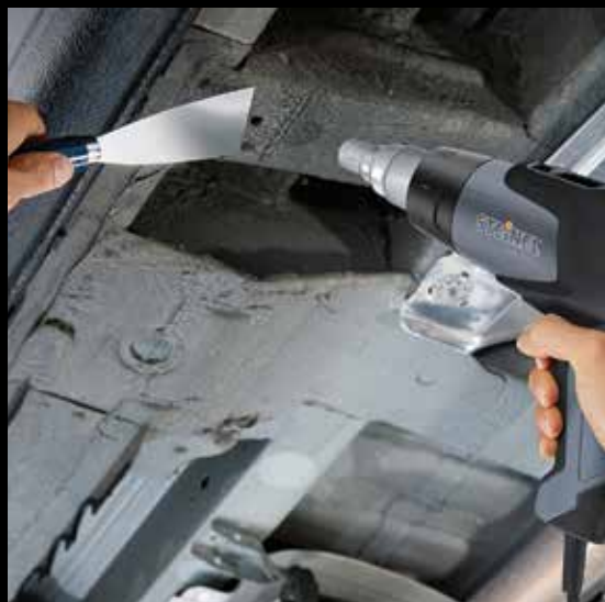
Удаление антикоррозийного покрытия кузова
