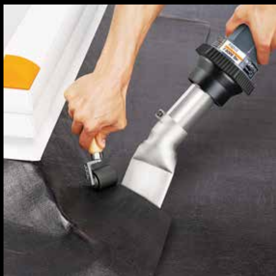
Сварка внахлестку легкого каркаса
