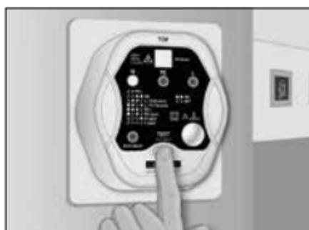
3. Ao carregar na tecla „TEST“ (3 seg.) é ativado o disjuntor diferencial FI/RCD a jusante.
