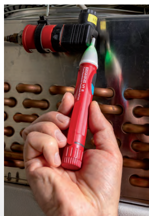
Prüfung eines Magnetventils
